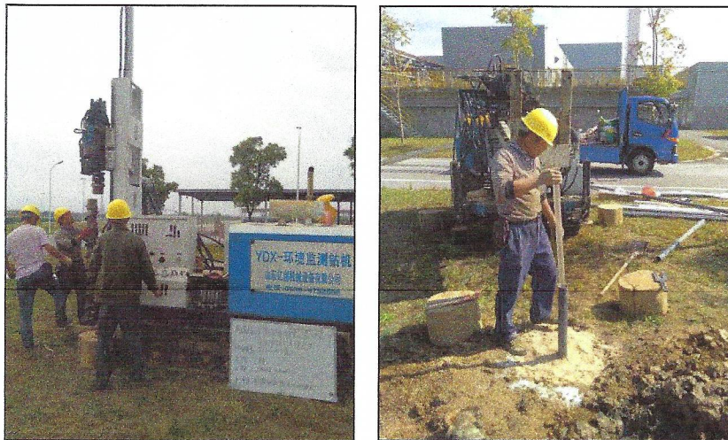
图 5-9 钻机机型及现场钻探施工
