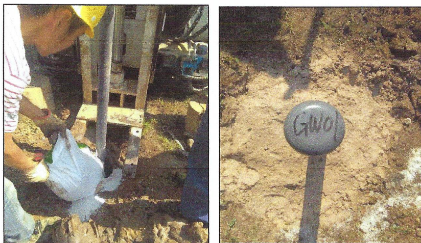
图 5-10 填砾和止水
